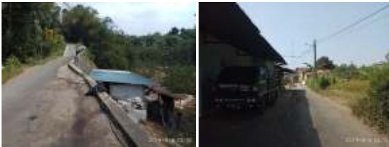
Gambar 2. 21. Kondisi Lalu Lintas Di Lokasi Studi
